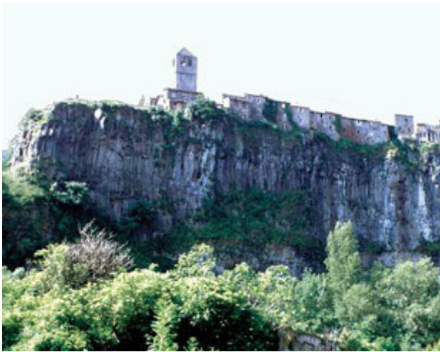
Cinglera basàltica de Castellfollit de la Roca.
